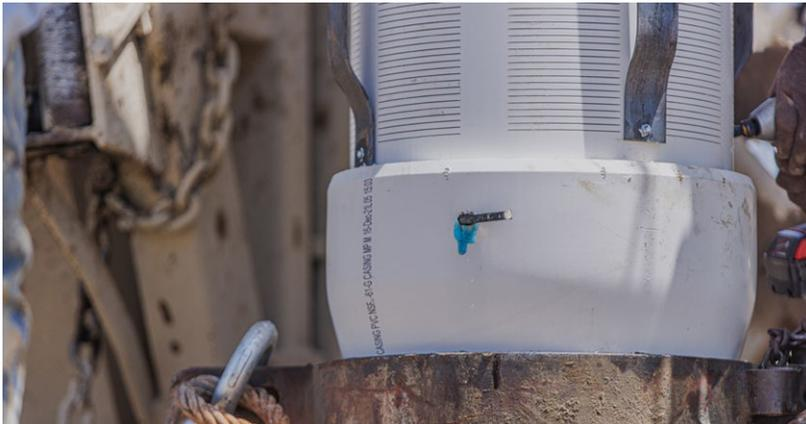
Simplemente no es posible superar a Certa-Lok en la velocidad de instalación en el fondo. La unión Certa-Lok puede montarse y desmontarse en solo segundos, a mano, sin necesidad de usar ninguna herramienta especial. Siga estos simples pasos para lograr un rápido montaje de las uniones:
