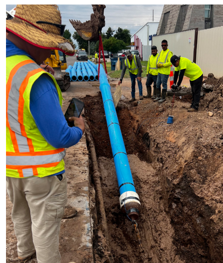
PREMIER FORAGE - SOUS L'AVENUE N. KLEIN JUSQU'À L'AVENUE N. WESTERN. TÊTE D'EXTRACTION, TÊTE PIVOTANTE ET ALÉSOIR ILLUSTRÉS
